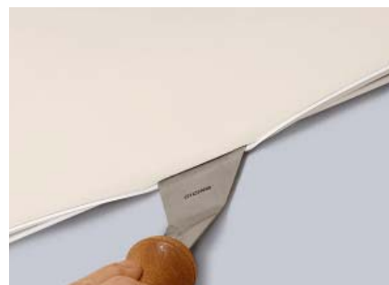
9. Специальный шнур – кедер – заправить лопаточкой в профиль, шагами по 20 см. Точно так же потолок можно будет снова снять.
