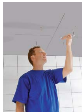
2. Установка винтов, затем замазывание отверстий.
