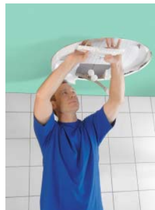
8. Полностью проломить внутри кант из стиропора.
