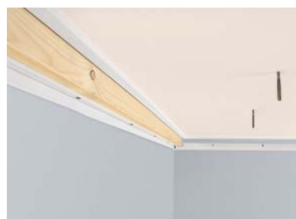
5. Используйте все отверстия в профиле при фиксации к стене или потолку. Затем либо наложить защитный кант по всей длине, либо обклеить уголок.
