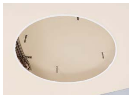
13. Проверить склейку и удалить временный крепеж для шлангов подводки.
