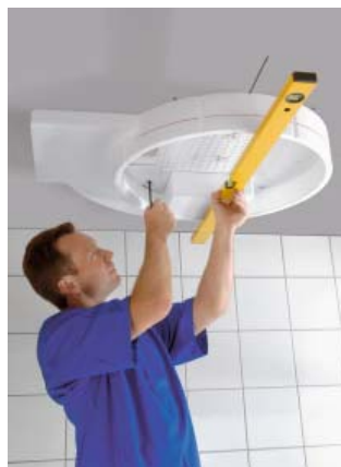
1. Примерка скрытой части на стиропоре и разметка отверстий под сверление.
